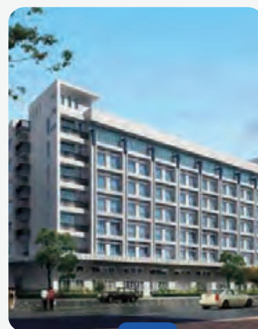
Здание с большими этажными площадями
