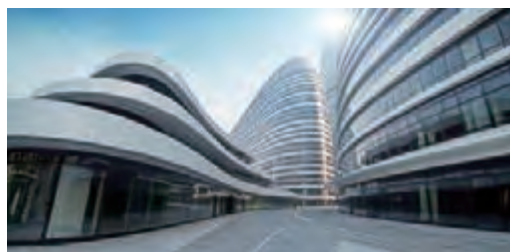
Здание с большими этажными площадями
