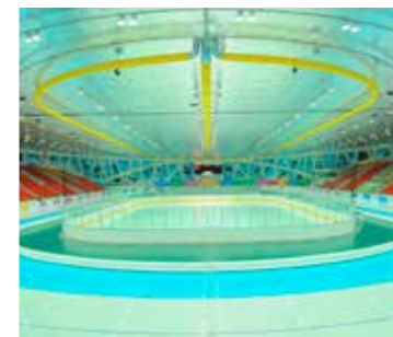
Текстильные воздуховоды применялись на ледовых аренах в подмосковной Коломне, в голландском городе Херенвене, в Астане
