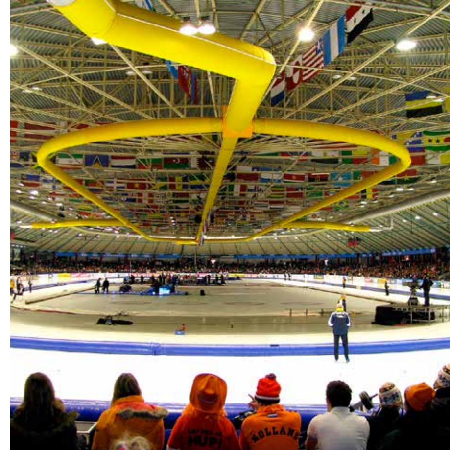
Текстильные воздуховоды применялись на ледовых аренах в подмосковной Коломне, в голландском городе Херенвене, в Астане
