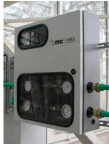
Принцип работы увлажнителей Carel серии MC основан на прямом испарении воды в потоке воздуха без подвода внешней энергии
