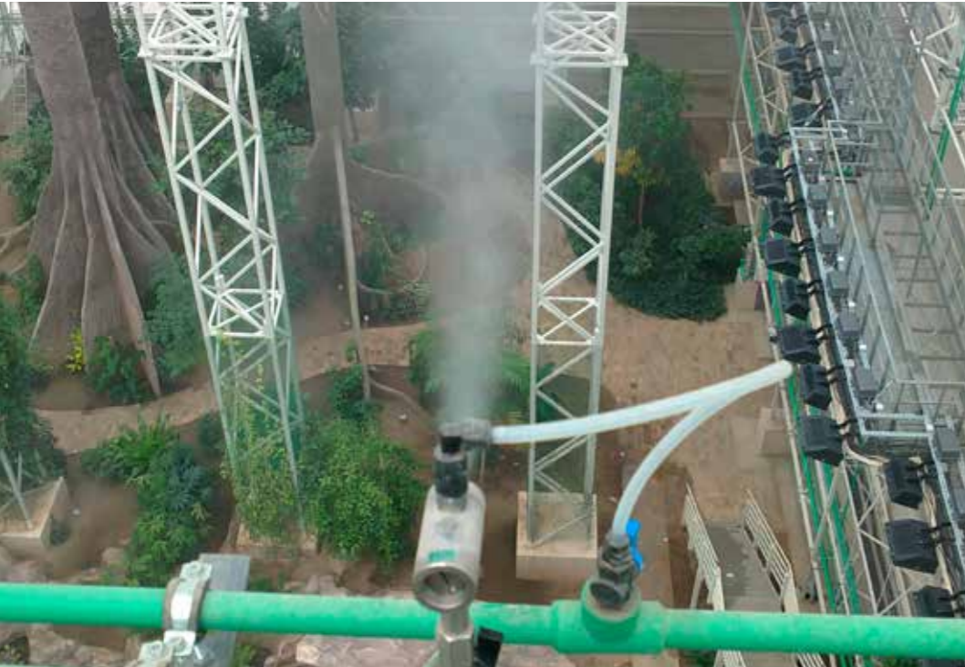
Принцип работы увлажнителей Carel серии MC основан на прямом испарении воды в потоке воздуха без подвода внешней энергии
